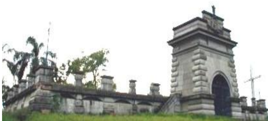
Caixa D'água do Portal.
