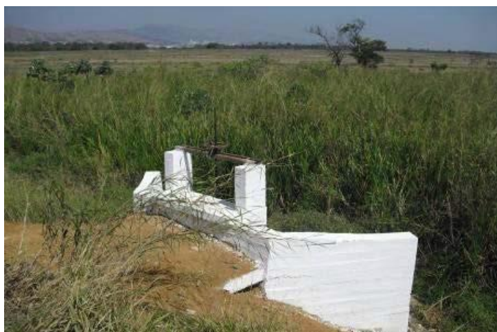
Figura 9: Comporta Localizada no Dique Parque das Árvores – é fechada quando da elevação das águas do Rio Paraíba.
