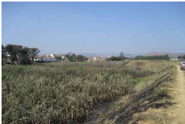
Figura 8: Dique de Proteção do Parque das Árvores – as águas são direcionadas para a Estação.
