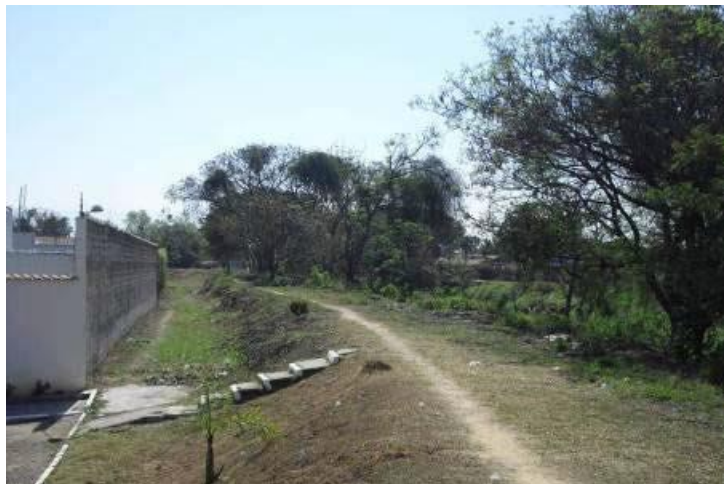
Figura 12: Dique Situado no Loteamento do Nino – vista lateral - proteção do bairro contra as cheias do Ribeirão Guaratinguetá.
