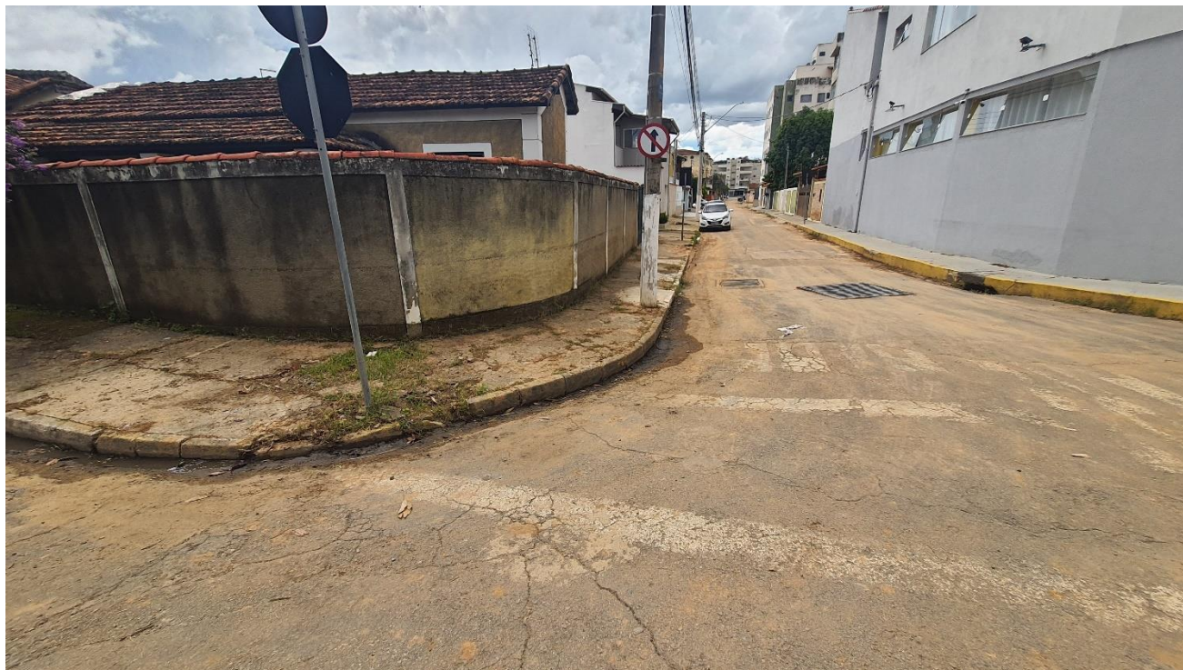
Figura 5: Transposição para o Rio Paraíba do Sul, por meio de canal na rua 8 - Região das Chácaras Agrícolas
