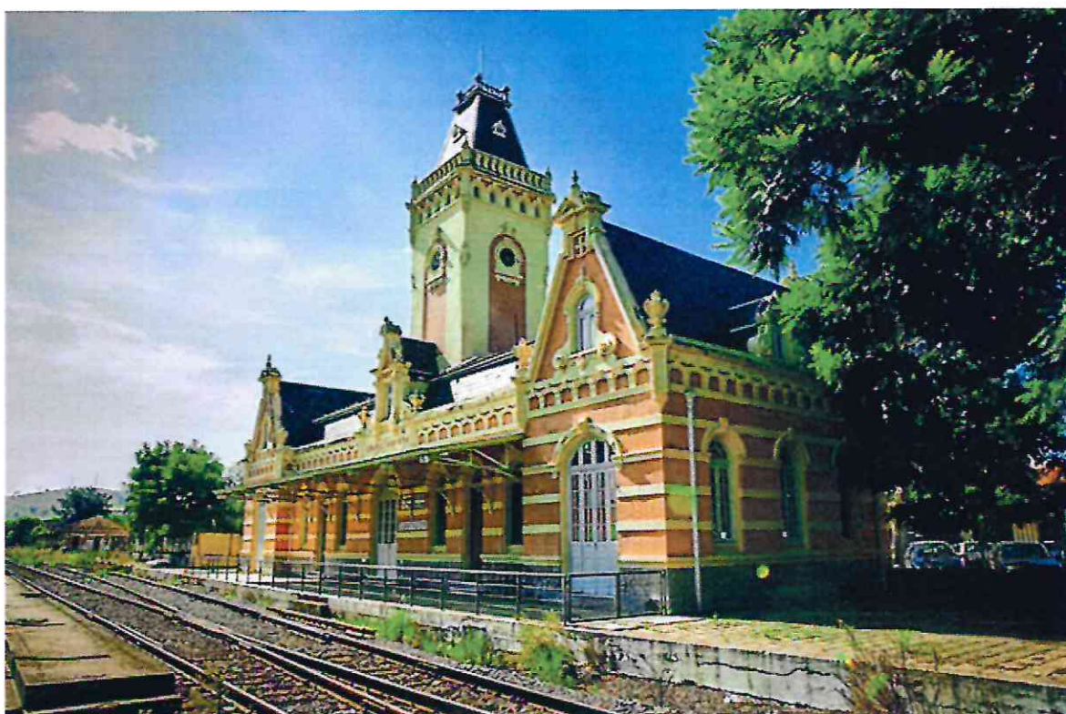
Estação Ferroviária de Guaratinguetá /SP.
