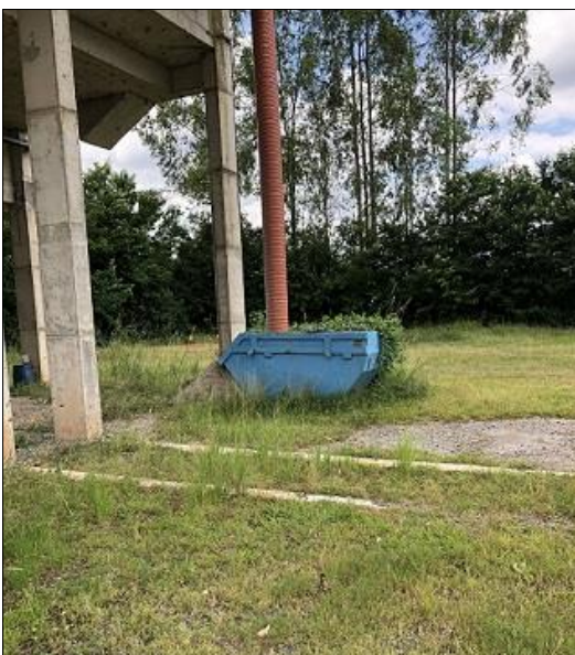
Foto C.6 - Caçamba para a Areia do Tratamento Preliminar.
