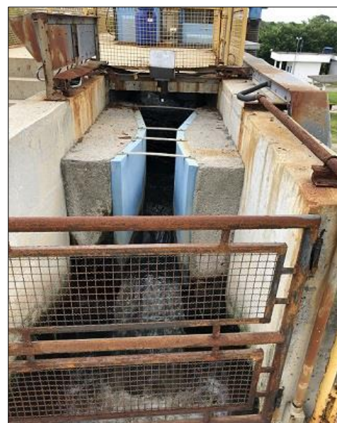
Foto C.7 - Calha Parshall.
