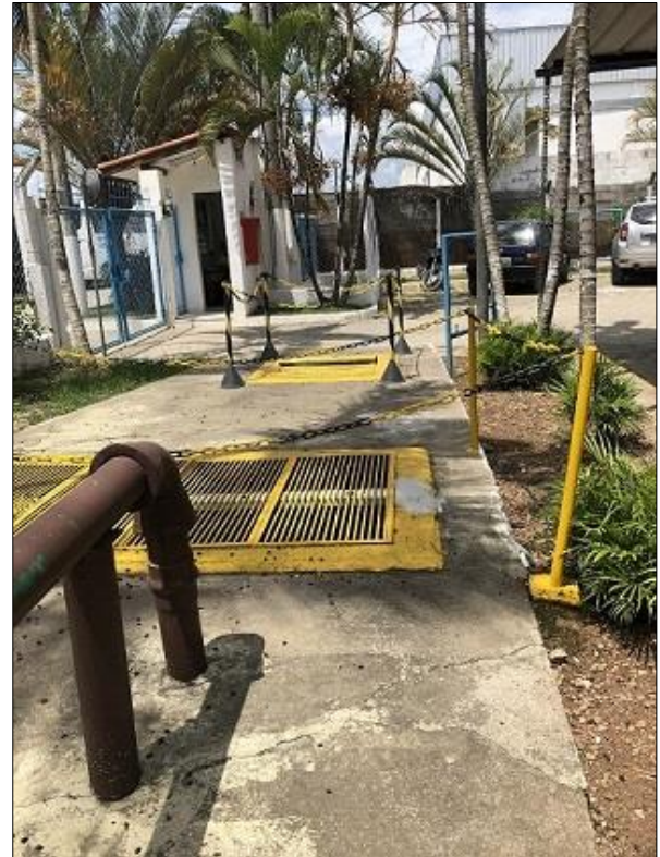
Foto A.2 - Vista do Poço de Sucção da Estação Elevatória Final.
