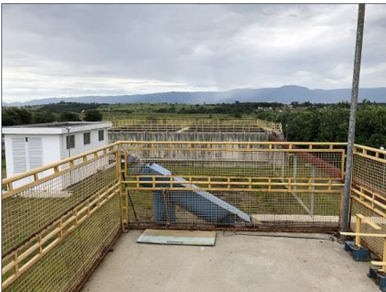
Foto C.5 - Detalhe do Parafuso Classificador da Caixa de Areia Mecânica.
