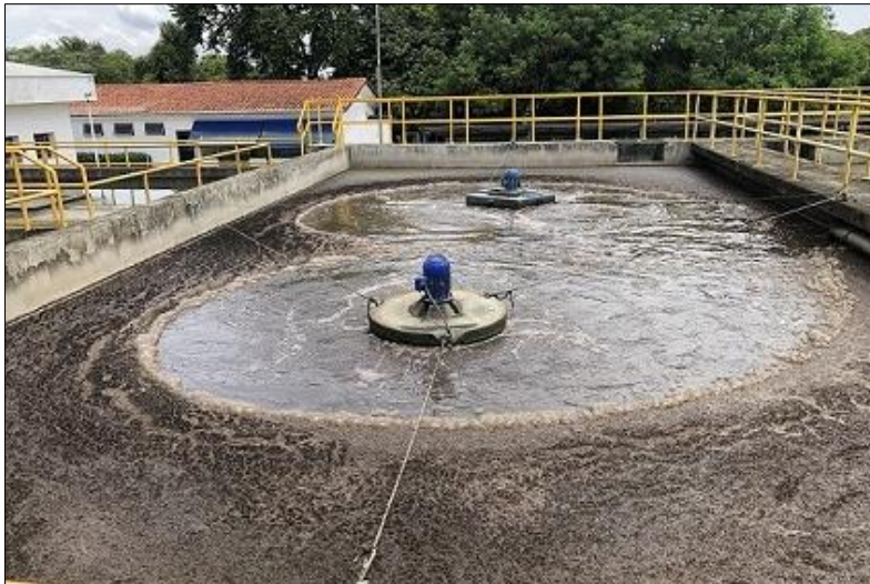
Foto A.11 - Tanque de Aeração.
