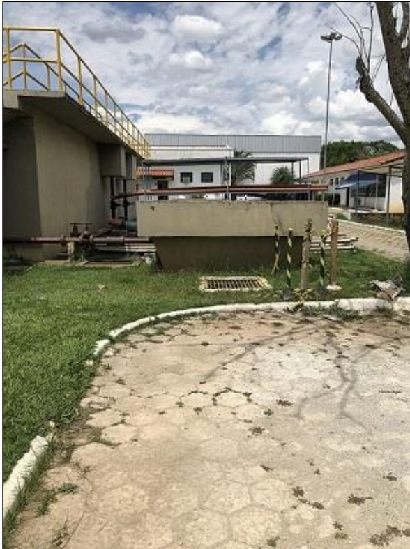
Foto A.1 - Entrada da ETE e Vista do Adensador.
