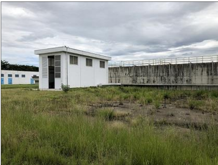
Foto C.12 - Casa dos Sopradores.
