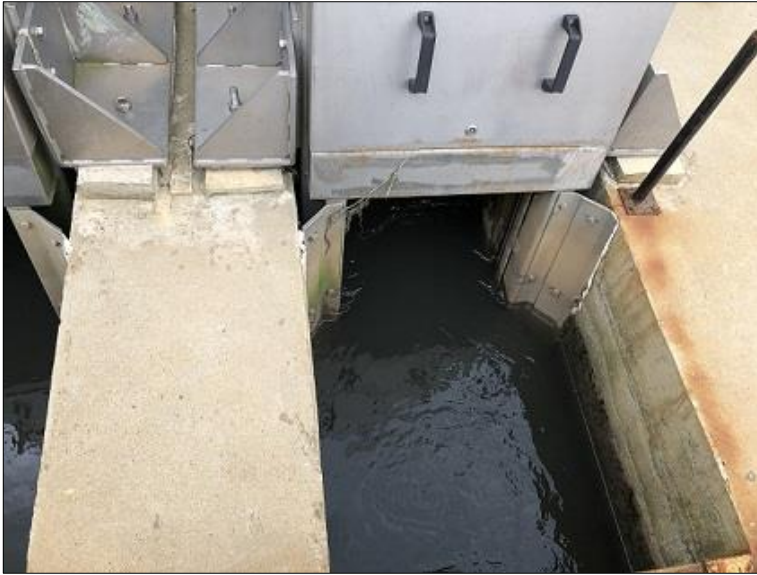
Foto C.1 - Entrada do Esgoto Bruto.
