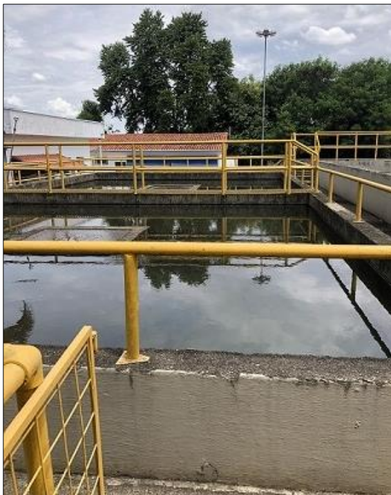
Foto A.12 - Vista dos Decantadores.
