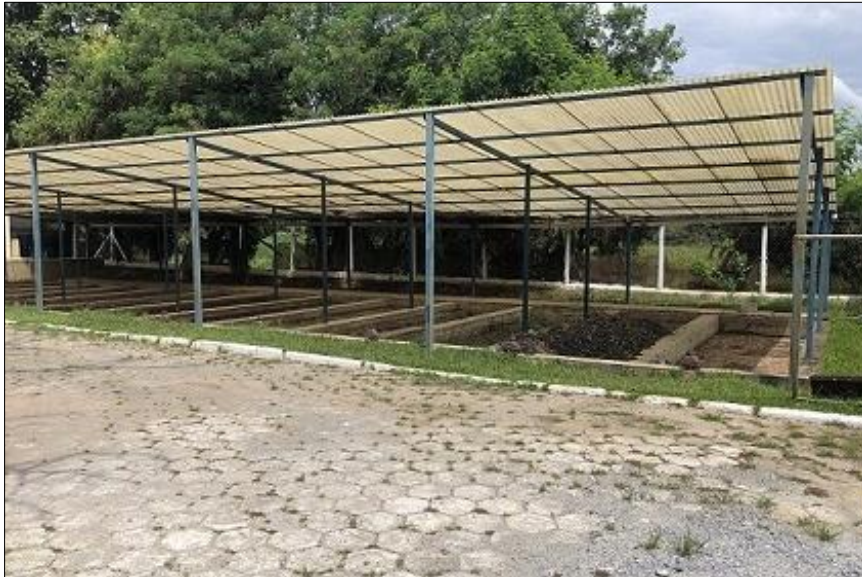
Foto A.14 - Leitos de Secagem de Lodo.
