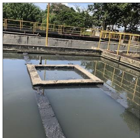
Foto B.9 - Vista dos Decantadores.
