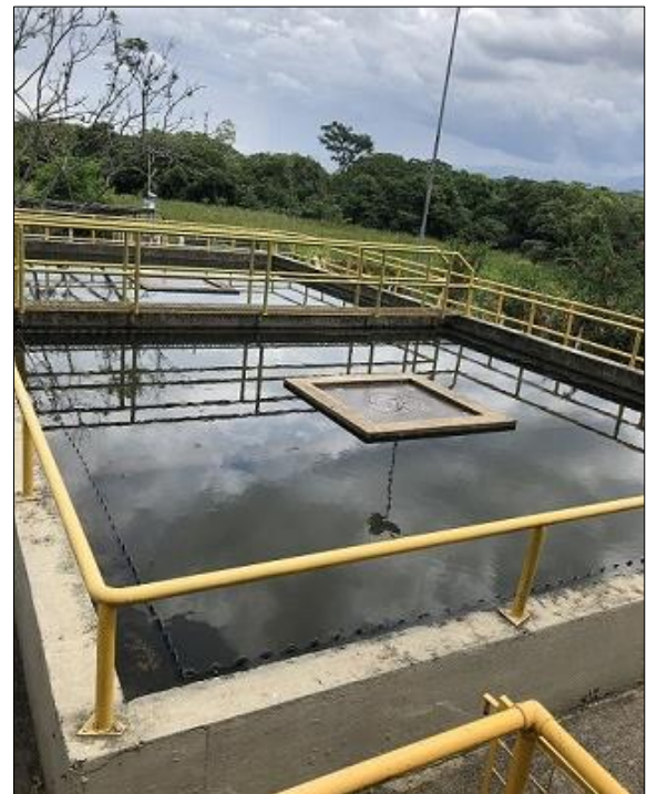
Foto A.13 - Vista dos Decantadores.
