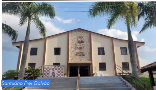
Casa de Frei Galvão
