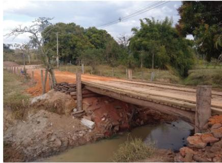
Foram realizadas reparo de cabeceiras, troca de vigas, substituição do assoalho, ampliação, dentre outras ações de reparo.
