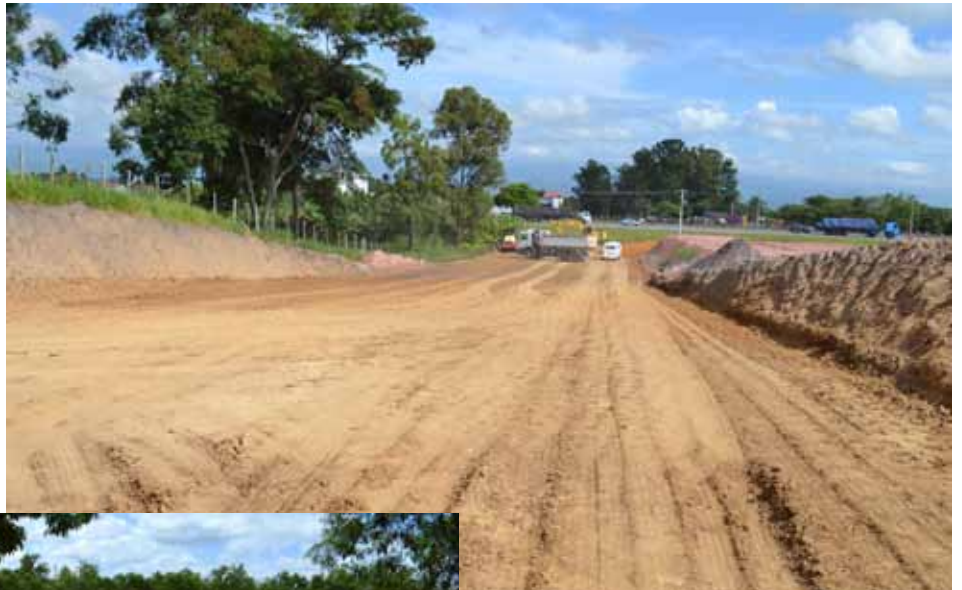
Drenagem e Pavimentação do Acesso à empresa ACG - Vista Alegre
