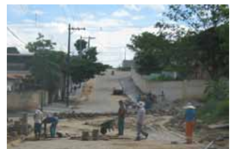
Obras no bairro Jardim Santa Luzia
