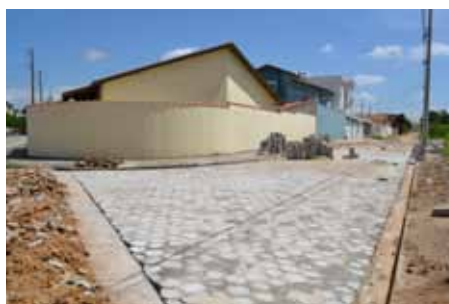
Pavimentação no bairro Jardim Bela vista
