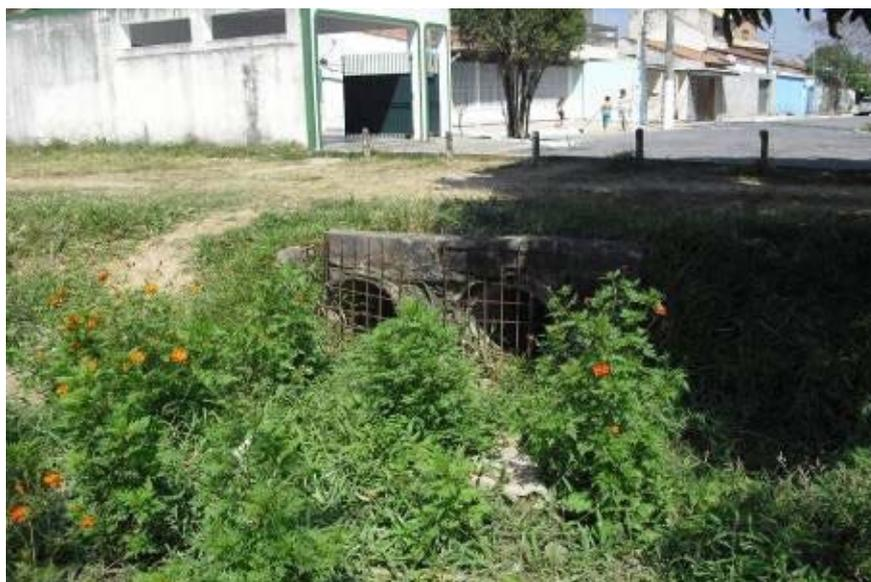
Foto 19 - Tubulação de Coleta e Transporte da Água Pluvial – passa sob a Rua José Amílcar Bedaque e conduz sua vazão para a Estação de Bombeamento Rony.
