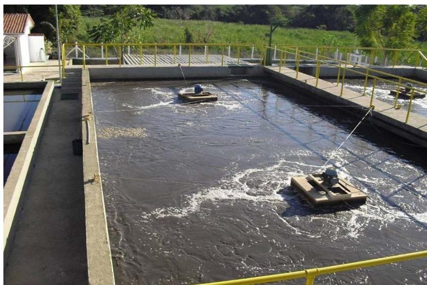
Foto 09 - ETE Campo do Galvão – Tanques de Aeração.
