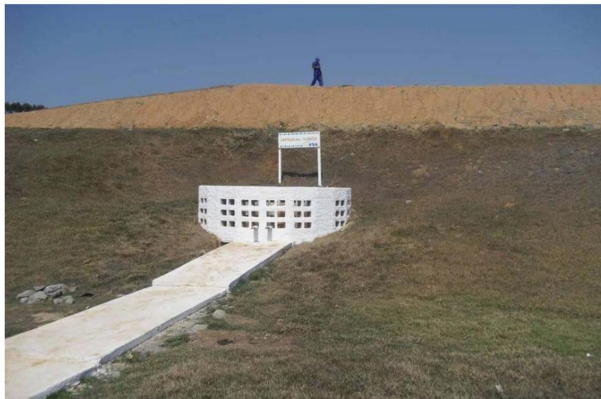
Foto 15 - Poço de Captação de Líquidos Percolados.
