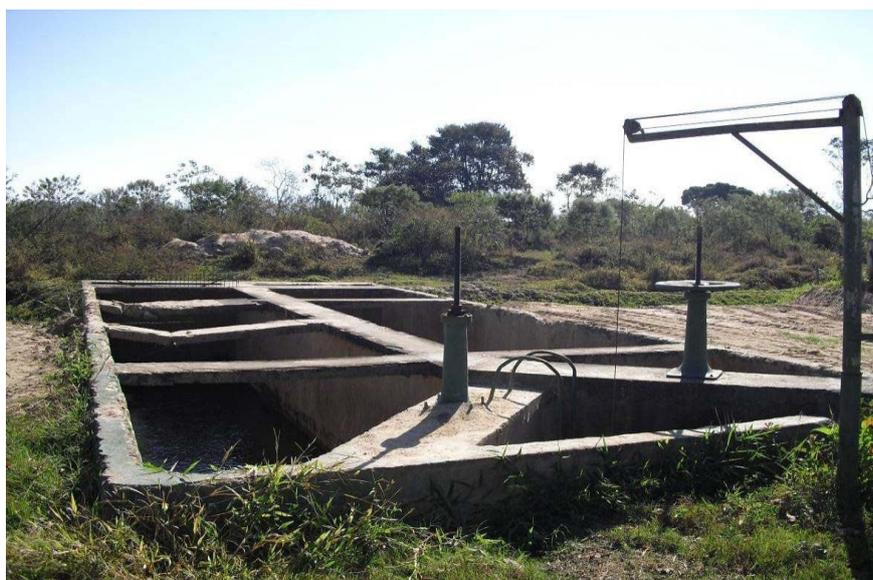
**Foto 02 - Caixa de Areia junto à Captação do Ribeirão Guaratinguetá.**
