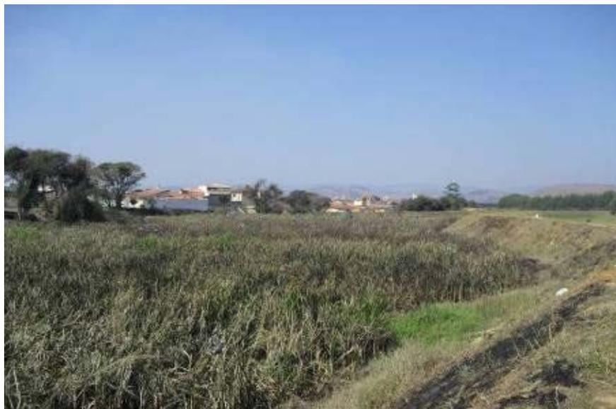
**Foto 22 - Dique de Contenção no Parque das Árvores – direciona as águas pluviais para a Estação de Bombeamento do Rony.**
