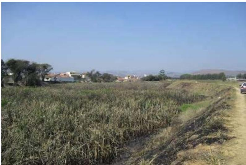
**Foto 20 - Dique de Proteção do Parque das Árvores – as águas são direcionadas para a Estação de Bombeamento do Rony.**
