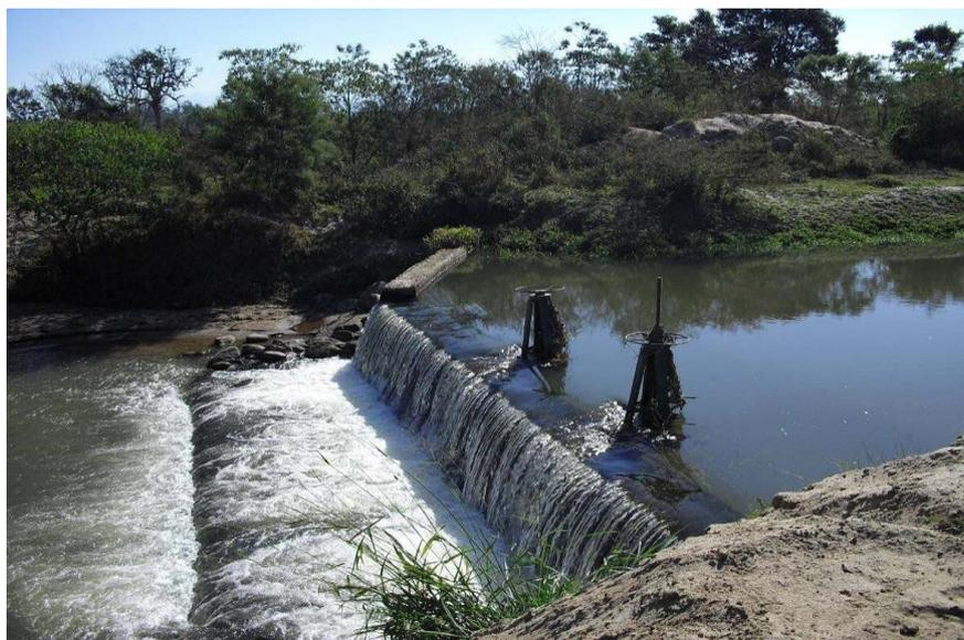
**Foto 01 - Barragem de Nível para Captação – Ribeirão Guaratinguetá.**
